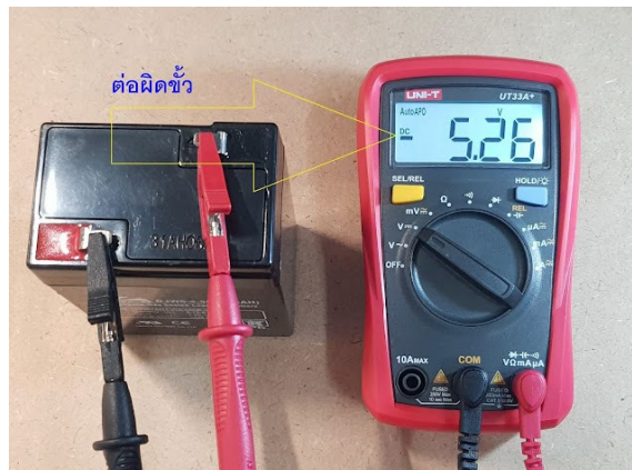
รูปที่ 87 การวัดแรงดันไฟ VDC ด้วยมัลติมิเตอร์ดิจิทัล
